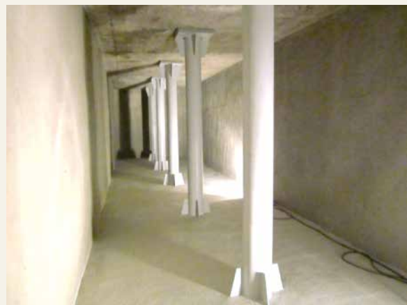
▲ 経年防火水槽の再生
