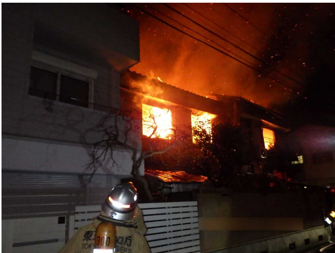
⑧住宅の2階からの延焼状況（7月）
