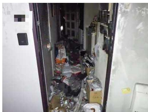
写真 18-4 出火室通路の焼損状況
