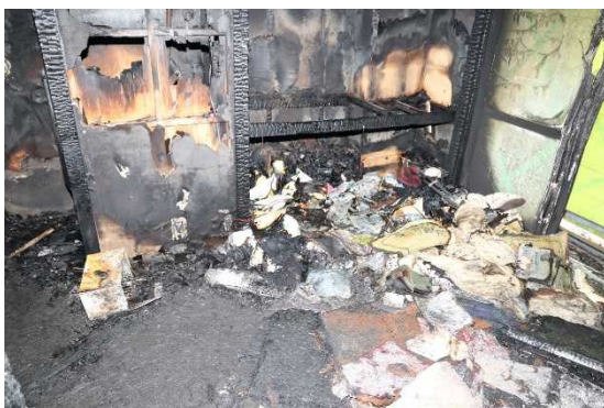
写真 14-1 居室内の状況
