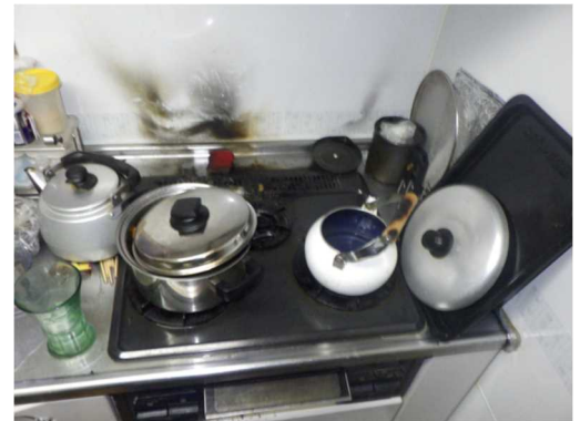
写真 7-6 台所の焼損状況
