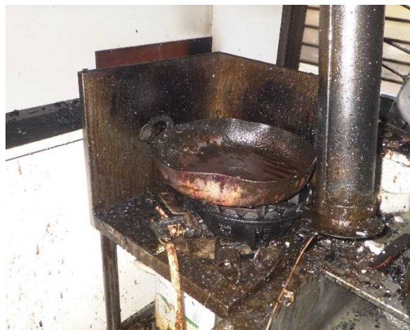
写真 19-2 厨房内の状況
