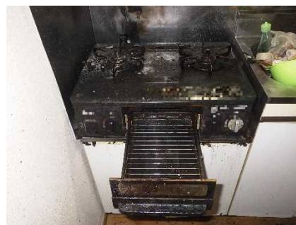
写真 7-5 グリルの焼損状況
