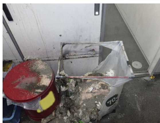
写真 10-5 焼損したごみ
