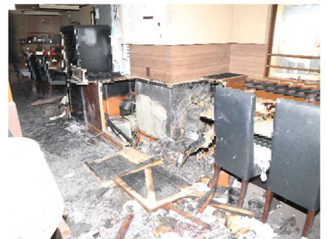
写真 32-1 焼損した客席状況
