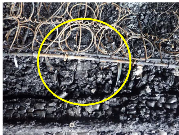
写真 18-7 出火箇所の蚊取り線香の状況
