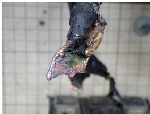
写真 16-3 電気配線の端子部分の状況
