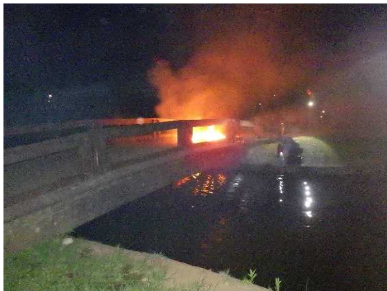
写真 1-1 延焼中の木造の橋
