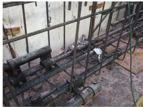
写真 16-5 作業周辺の状況
