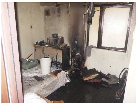
写真 21-1 焼損した宿泊室の状況
