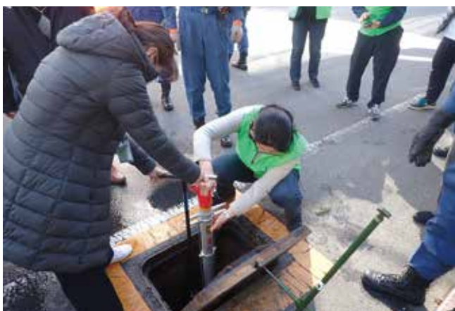
初期消火訓練（スタンドパイプ）
