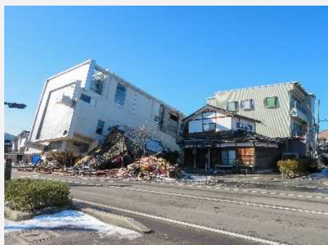
輪島市の被害状況
