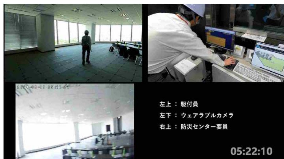
5分22秒 防災センター勤務員が中央監視盤で空調停止を確認
