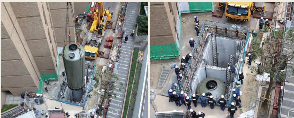
▲ 危険物タンクの設置時の状況
