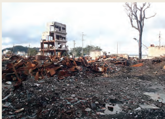
▲ 能登半島地震における市街地火災焼け跡の状況
