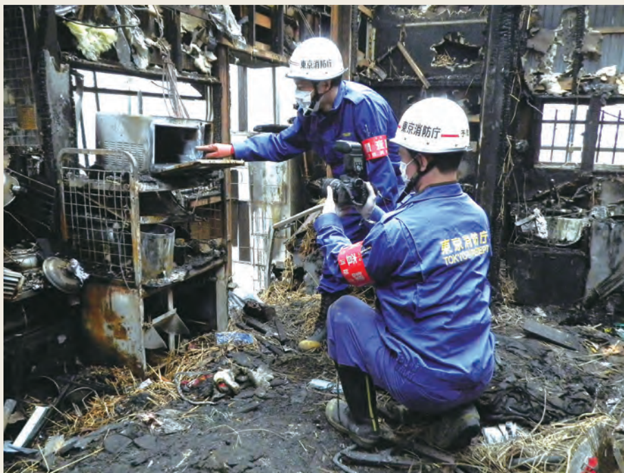
▲ 現場見分の状況
