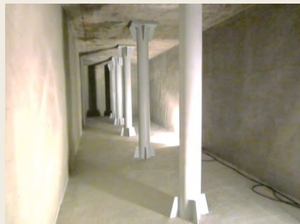
▲ 経年防火水槽の再生
