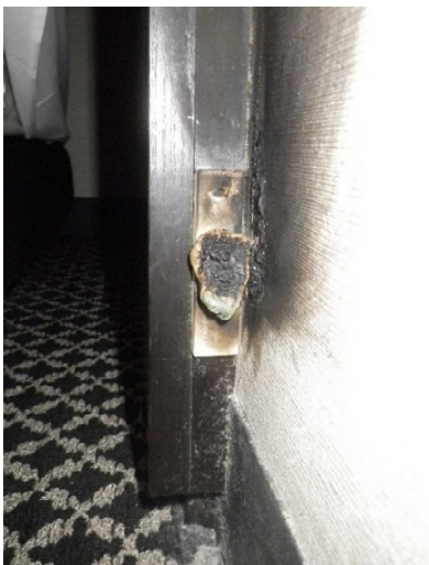
写真 21-3 宿泊室のコンセントの状況
