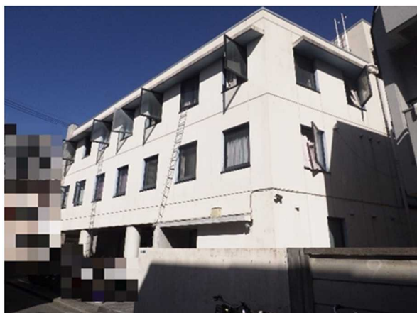
写真 32-1 避難はしごの使用状況 1
