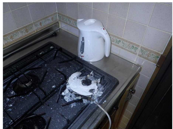
写真 15-2 電源プレートの焼損状況
