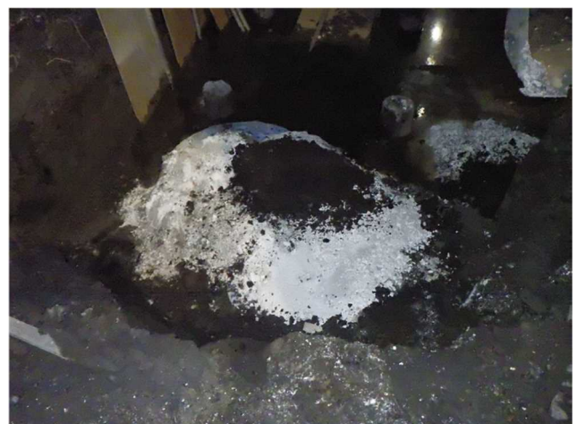
写真 16-4 生石灰の状況
