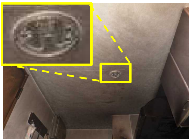
写真 18-9 台所天井の焼損状況及び 住宅用火災警報器の設置状況
