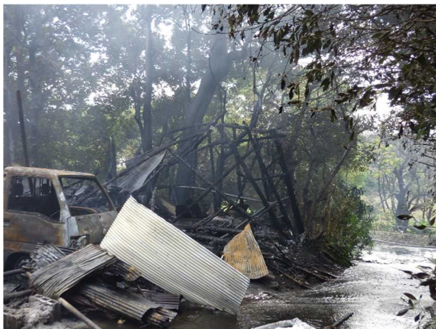
写真 25-3 焼損した倉庫の状況
