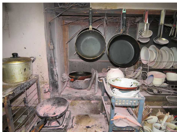
写真 9-2 ガスこんろ周囲の焼損状況
