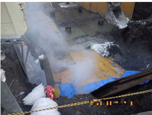
写真 16-3 生石灰の保管場所の状況
