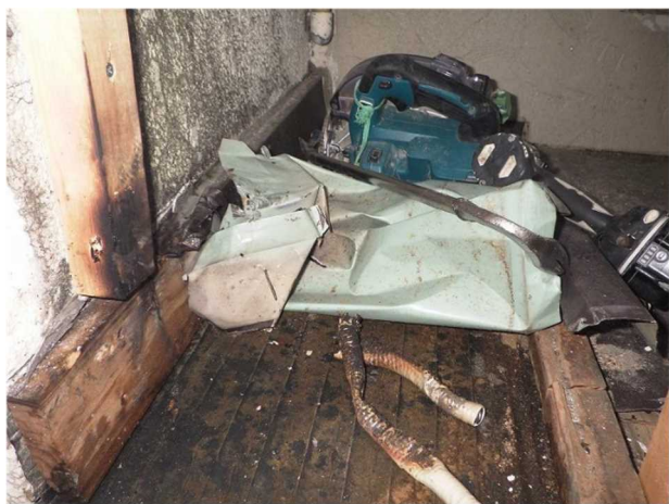
写真 16-1 作業部分の電動工具の状況
