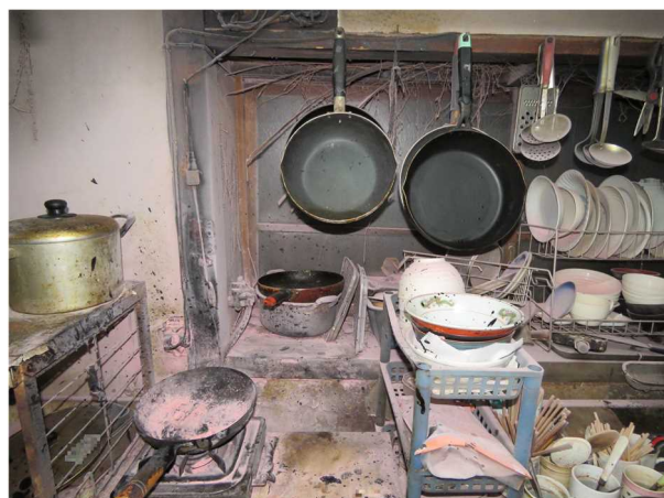
写真 9-2 ガスこんろ周囲の焼損状況
