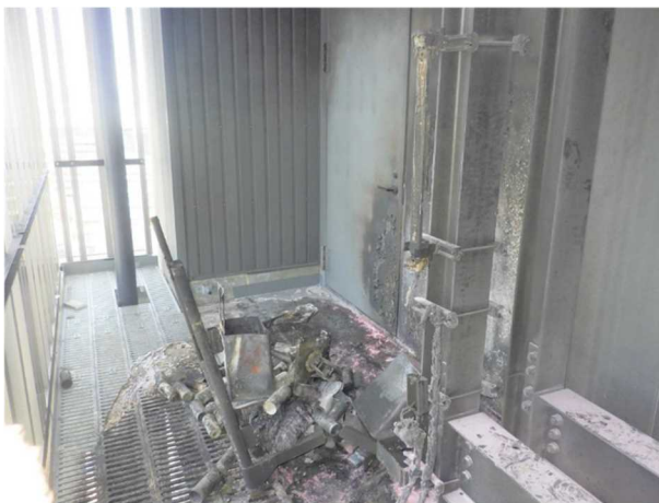
写真 11-1 工事用屋外作業通路の焼損状況
