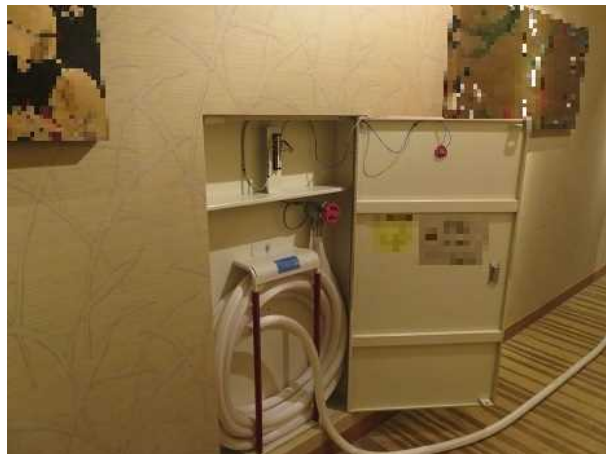
写真 30-2 使用した屋内消火栓設備の状況
