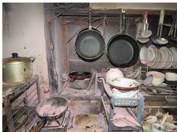
写真 9-2 ガスこんろ周囲の焼損状況
