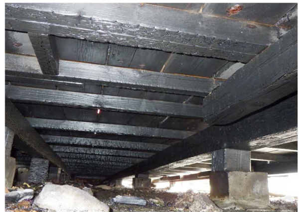
写真 20-2 床下の焼損状況
