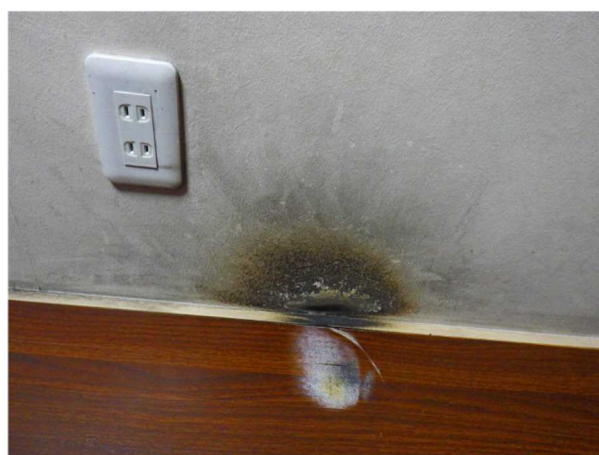
写真 6-9 内壁の焼損状況
