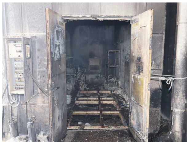
写真 7-6 一般取扱所の焼損状況
