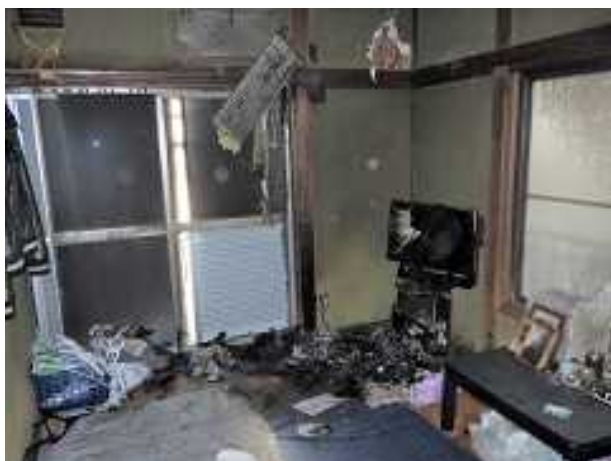
写真 14-3 居室内の焼損状況
