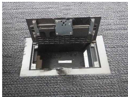
写真2 金属製カバーを展開した状況
