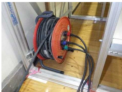
写真7 火災発生時の設定状況
