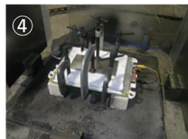
④ 小ピット内に煉瓦を足にする形で 配置し、ケーブル類を配線
