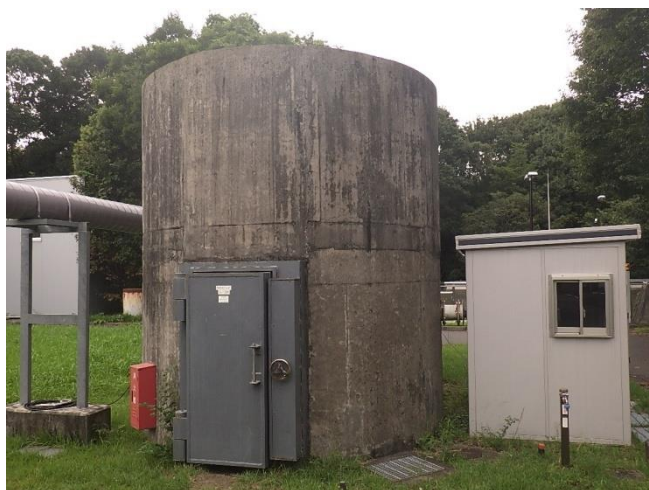
図 3.1 爆発試験用小ピット-1 と側室
