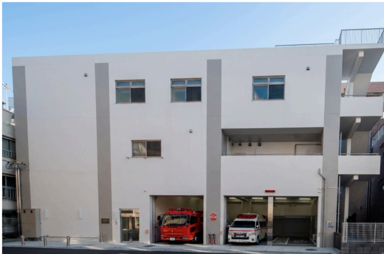
令和8年2月に事務開始した東駒形出張所新庁舎
