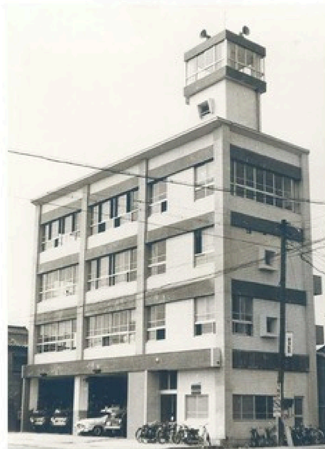
昭和39年に落成した本署 (旧東駒形出張所)
