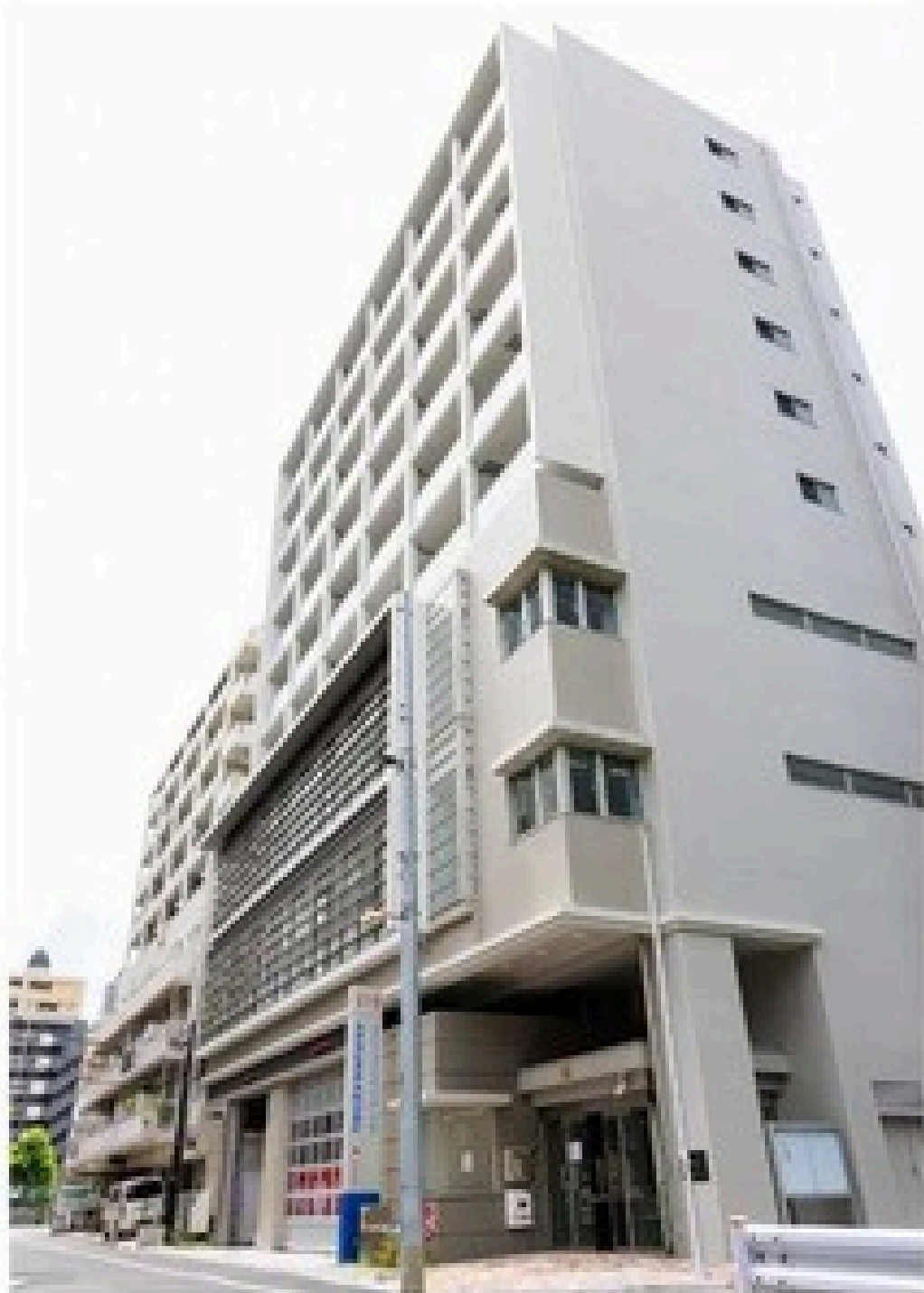
令和6年5月に竣工した錦糸町出張所
