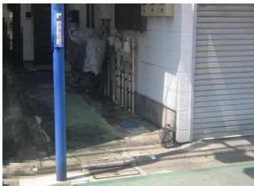
写真3 火災発生場所の状況
