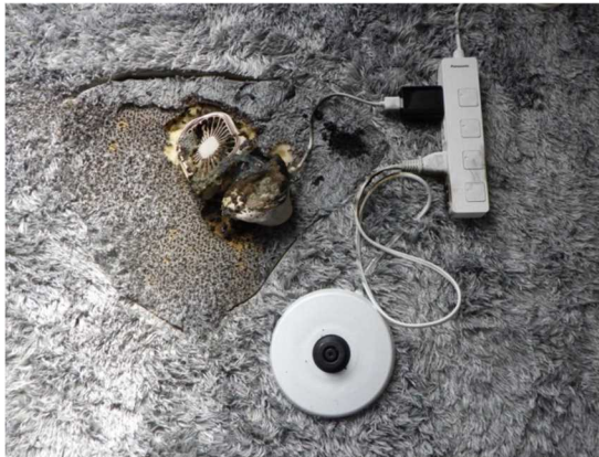
写真 10 居室内の焼損状況
