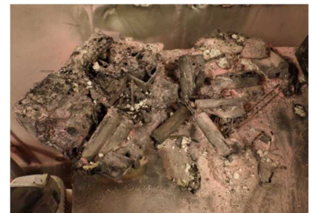
写真9 バッテリーの焼損状況
