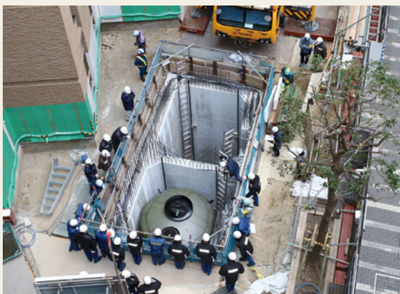
▲ 危険物タンクの設置時の状況
