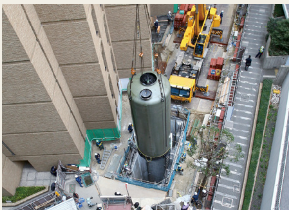
▲ 危険物タンクの設置時の状況
