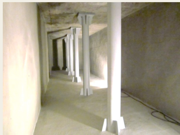
▲ 経年防火水槽の再生
