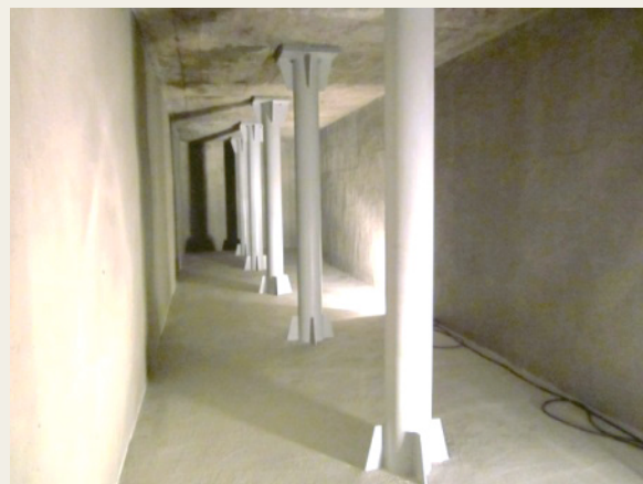
▲ 経年防火水槽の再生
