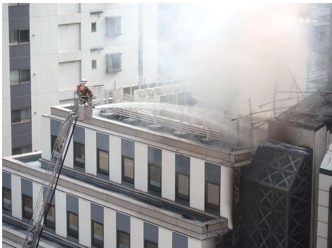
②消防隊による消火活動状況（3月）
