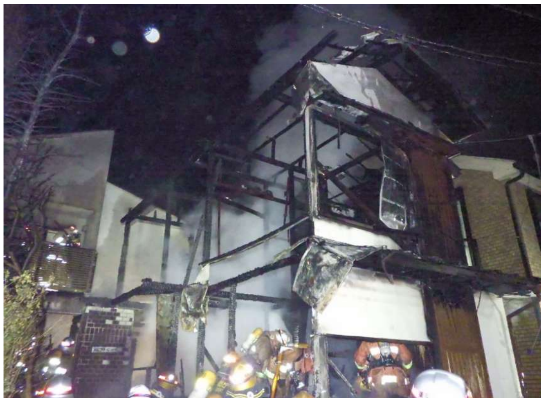
①住宅の延焼状況（2月）
