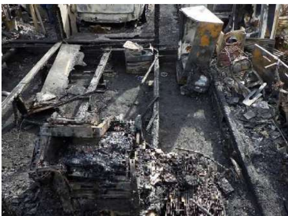
写真 11-1 出火室の焼損状況
