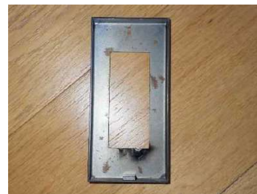
写真 21-3 金属製カバーの状況
