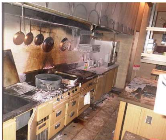
写真 7-1 厨房内全体の状況
