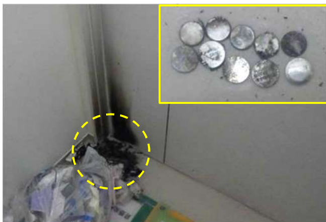
写真 30-3 廃棄物保管庫の焼損状況
