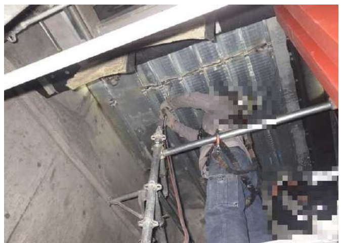
写真 16-4 作業中の状況を再現
