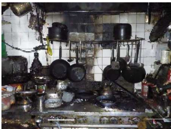
写真 19-1 厨房内の状況
