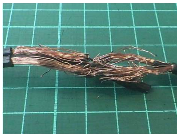
写真 26-2 コードの焼損状況
