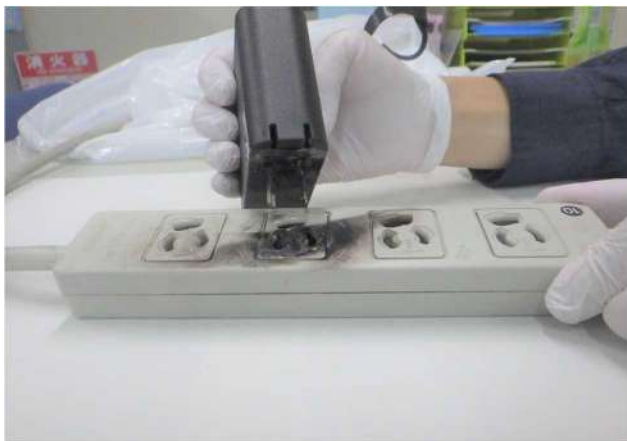
写真 26-3 テーブルタップの状況
