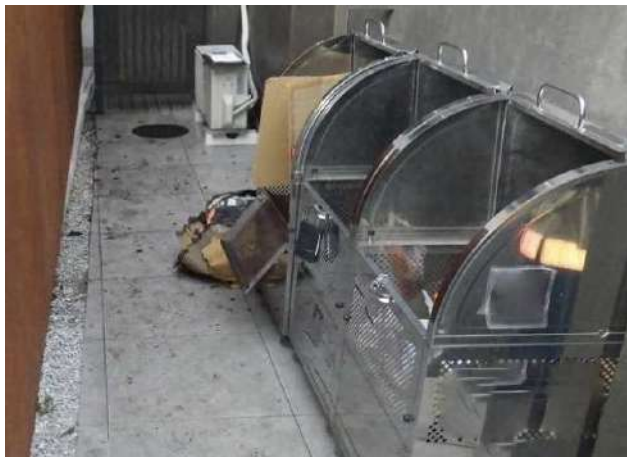
写真 1-1 屋外ごみ捨場の状況
