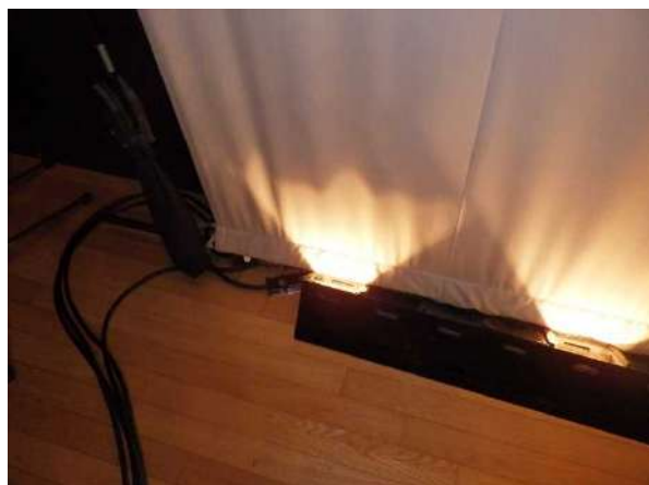
写真 31-1 カーテンと照明器具の位置
