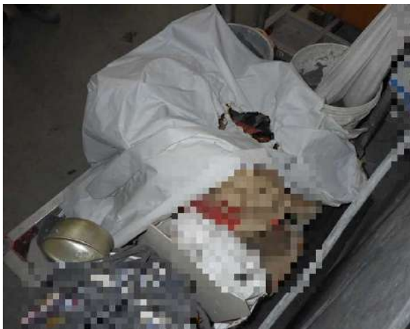
写真 16-3 防災シートの焼損状況
