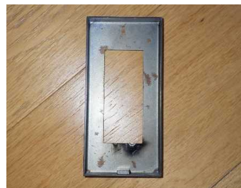
写真 21-3 金属製カバーの状況
