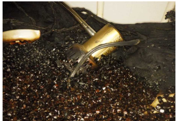
写真 30-2 クリップライトの焼損状況
