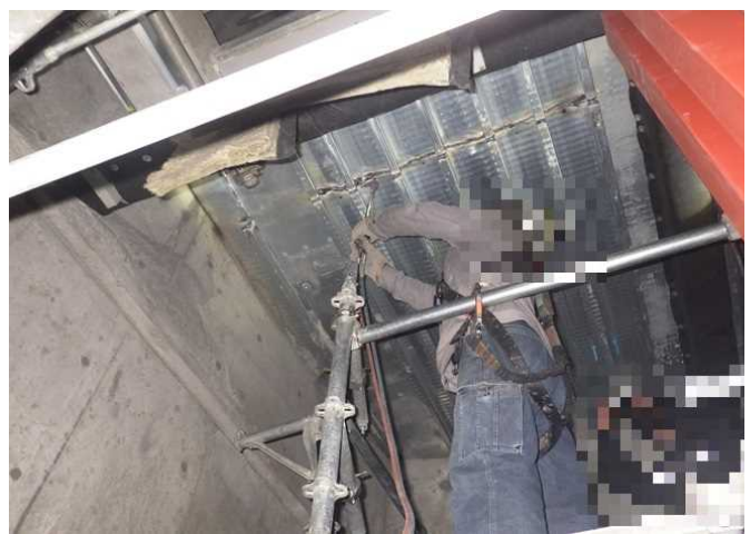
写真 16-4 作業中の状況を再現
