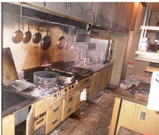
写真 7-1 厨房内全体の状況
