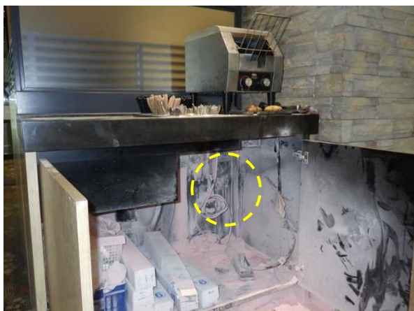
写真 32-1 キャビネット周囲の状況
