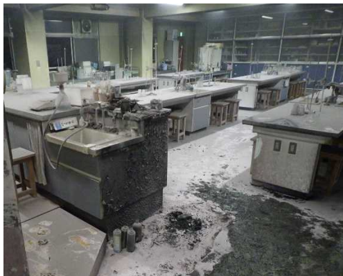
写真23-3 化学室の焼損状況
