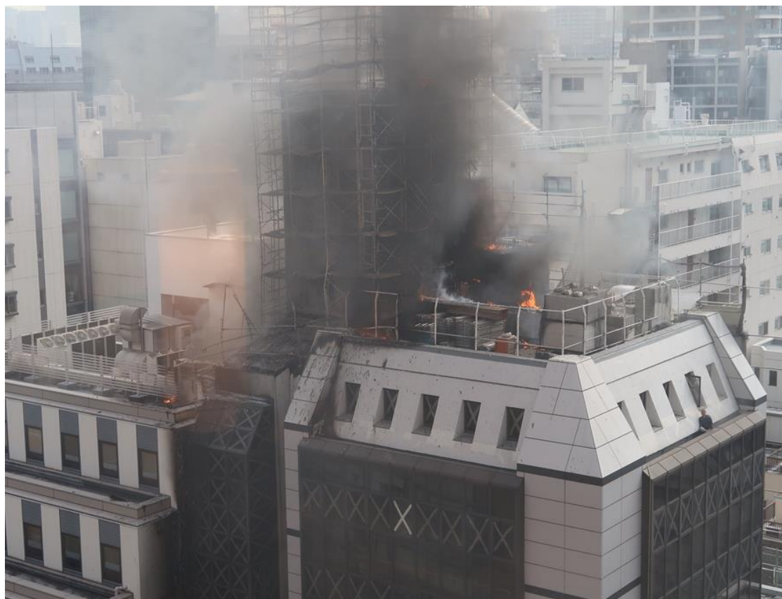
①解体中の建物の延焼状況（3月）
