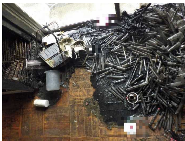
写真 10-4 出火箇所の状況
