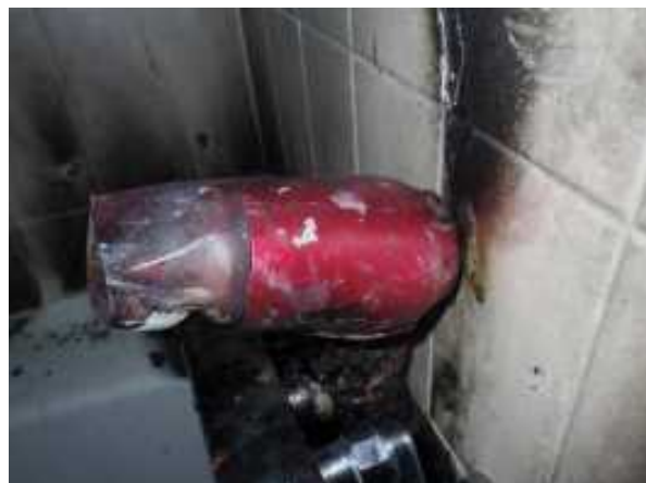
写真 27-2 ドライヤーの焼損状況
