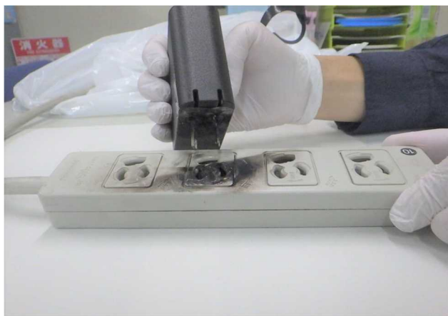
写真 26-3 テーブルタップの状況
