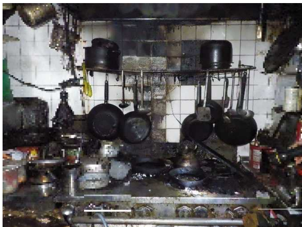
写真 19-1 厨房内の状況
