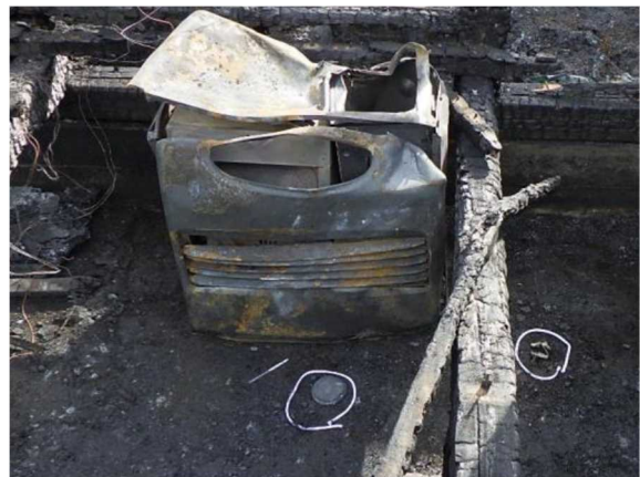
写真 11-2 破裂したスプレー缶の状況
