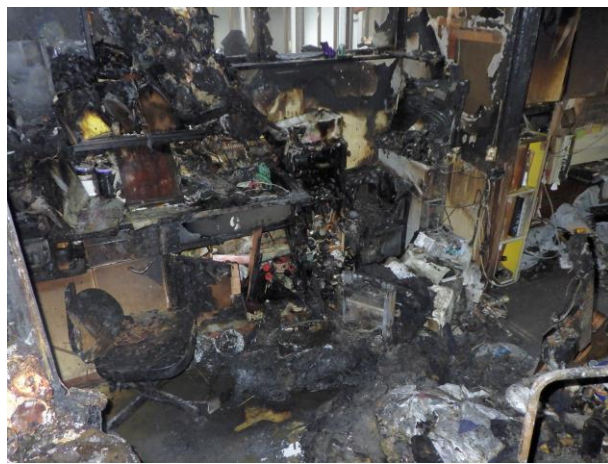
写真 14-7 電気ストーブ付近の状況
