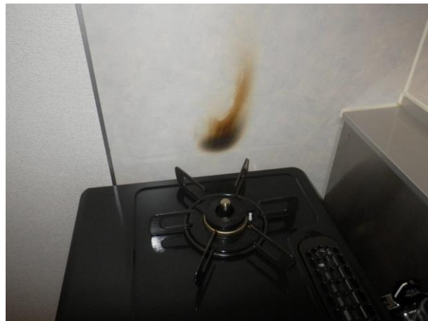
写真 7-2 内壁の焼損状況
