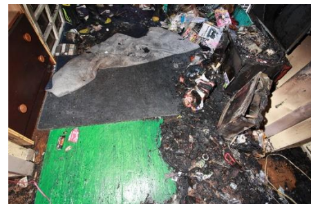
写真 11-2 居室の焼損状況
