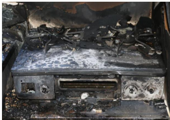
写真 18-2 ガステーブルの焼損状況
