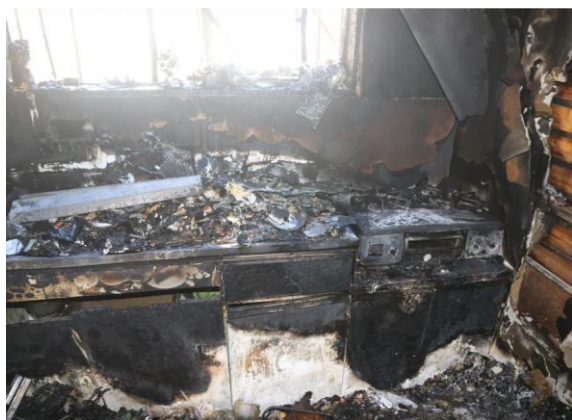
写真 18-1 台所の焼損状況
