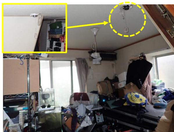
写真 18-5 1階リビングキッチンの焼損状況 写真 18-6 電池を取り外した住警器の状況
