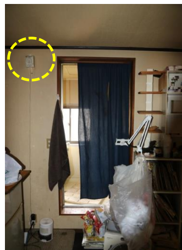
写真 18-7 住警器の設置状況
