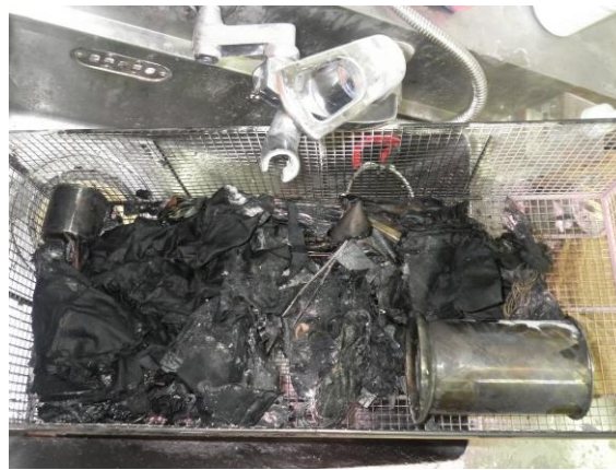
写真 23-2 医療器具等の焼損状況
