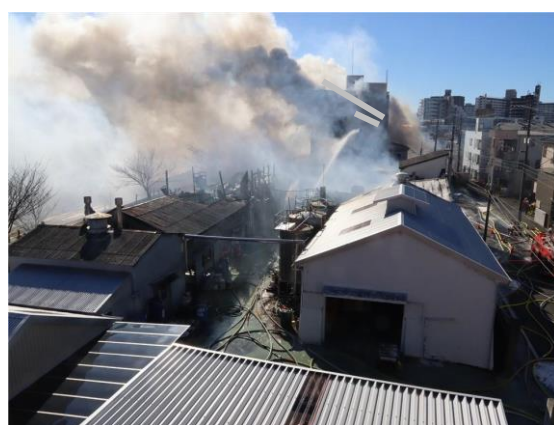
写真 24-1 周囲の建物への延焼状況
