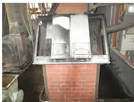
写真 25-1 焼却炉の状況
