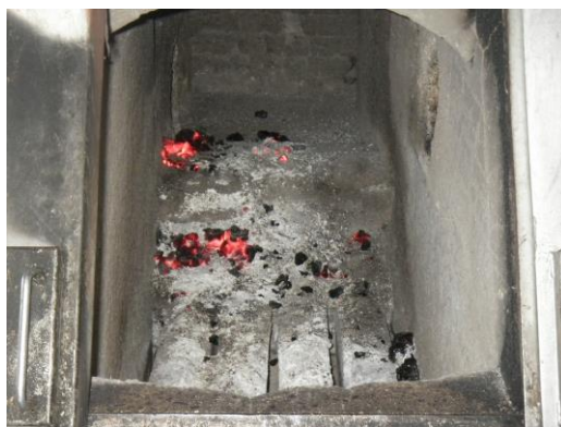
写真 25-2 焼却炉内の状況
