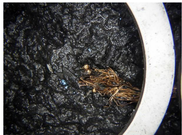
写真 25-2 焼損したコードの短絡状況
