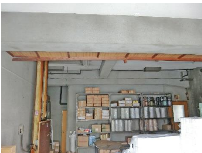
写真 26-1 倉庫内の状況
