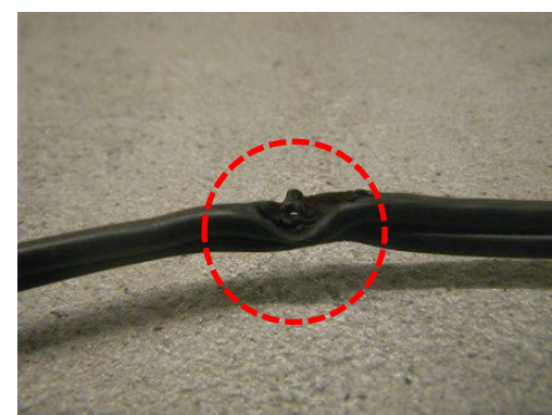
写真 27-3 コードの焼損状況
