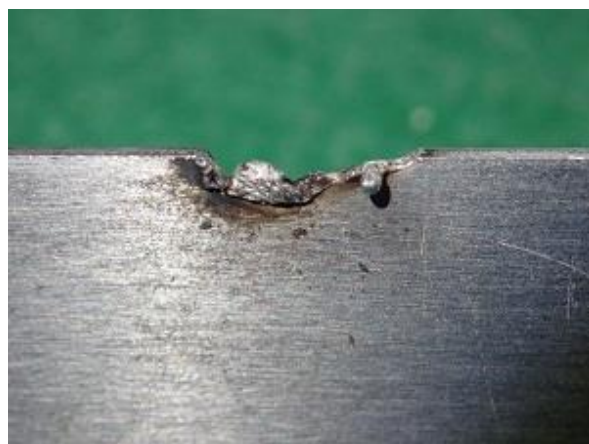
写真 27-5 コンセントカバーの焼損状況
