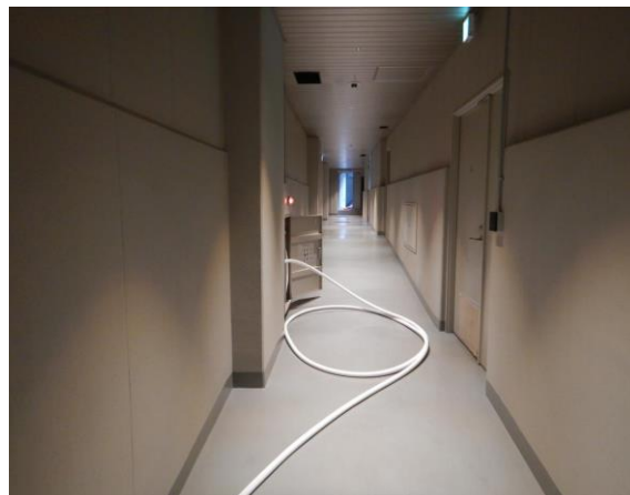
写真 30-4 延長した屋内消火栓設備の状況
