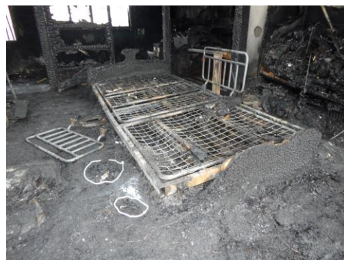
写真 14-3 居室内の状況
