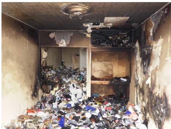
写真 14-1 居室内の状況
