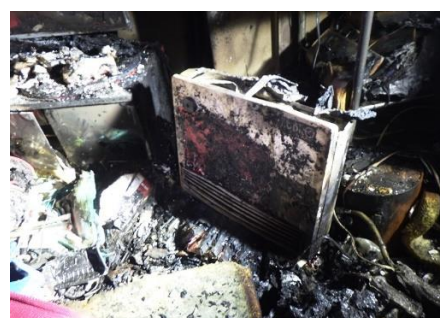
写真 11-1 出火箇所の状況
