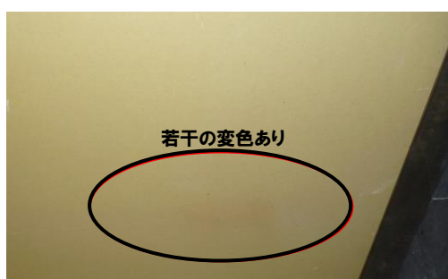
図7 加熱検証後の石膏ボード仕上げ状況 (離隔距離 3 cm)
