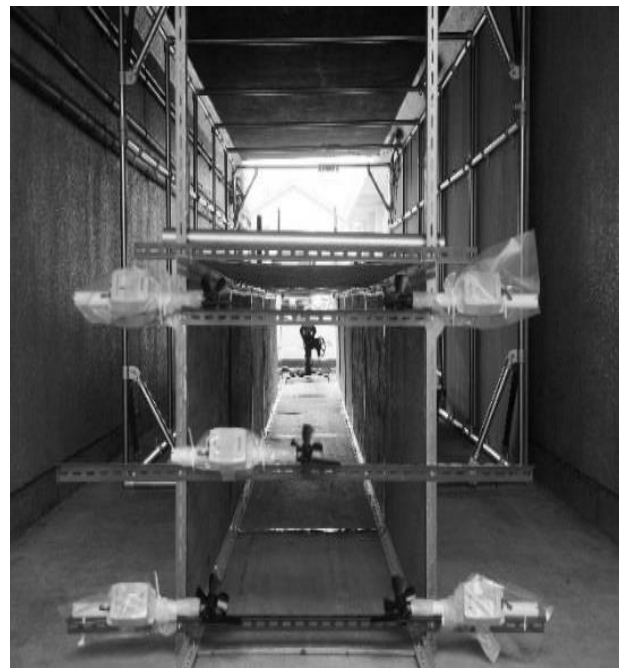
写真6 風速計設定状況(検証1)
