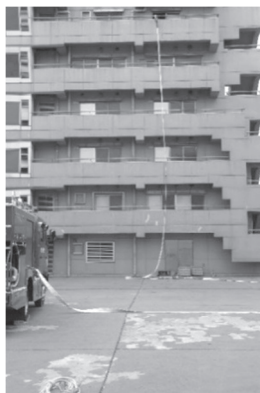
写真5 ホース設定状況 (吊上げ)
