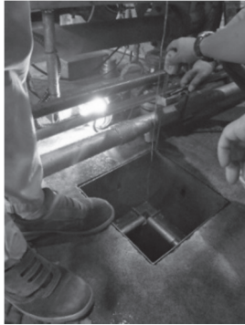
写真 14 吸水落差測定状況
