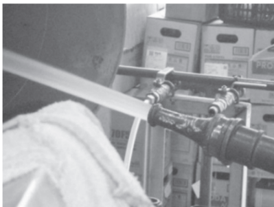
写真 16 落差 8.3mでの放水状況
