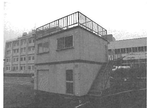
写真 訓練ハウスの外観
