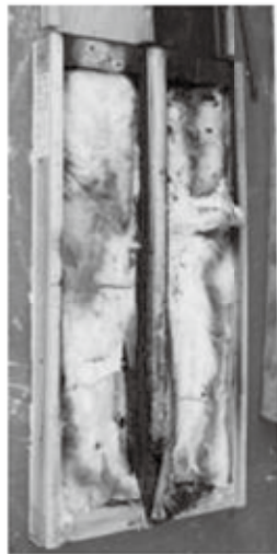
写真2 外装材取り外し 実験No. 1 基本設定
