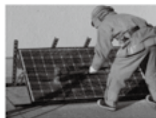
写真 23 破壊状況③ (大ハンマーで破壊)
