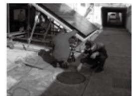
写真30 マンホール計測
