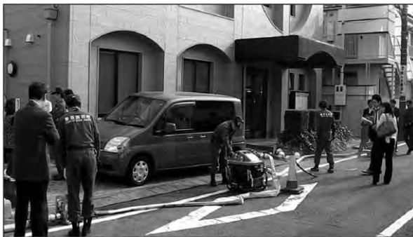
写真1 可搬ポンプの部署状況
