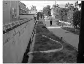
写真6 呼称65ホース延長状況
