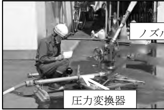
写真4 放水位置付近
