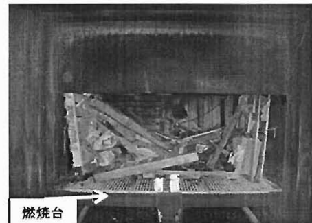
写真3 燃焼室の状況
