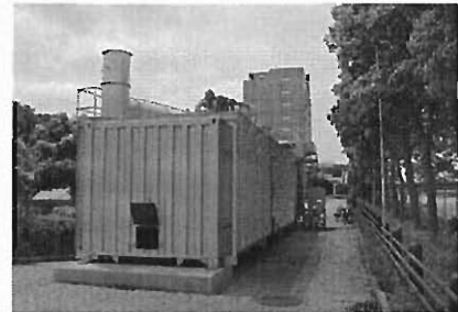
写真2 コンテナ訓練施設燃焼室側
