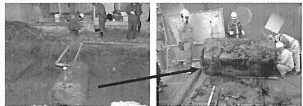
図 11 廃油タンク及びタンク底部
